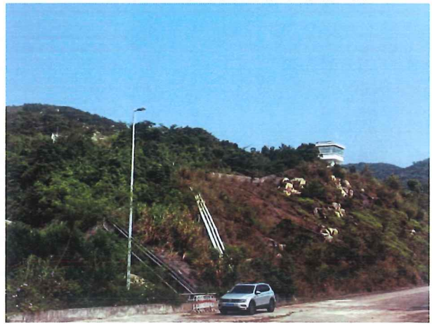
12 输水管沟周边边坡绿化防护情况
