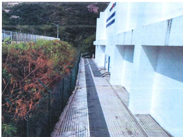
01 水箱周边永久盖板排水沟
