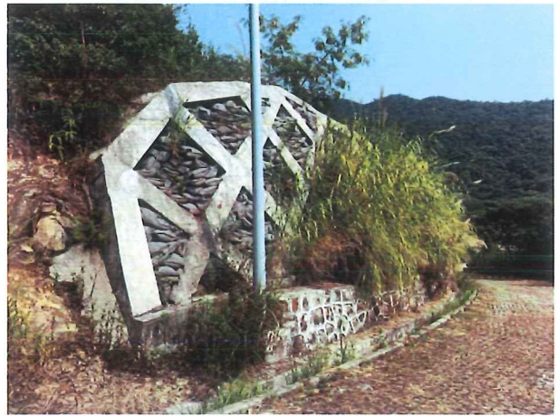
10 登山道两侧网格护坡现状
