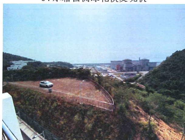
06 水箱南侧边坡防护情况及平台植草、栽植乔、灌木等绿化情况
