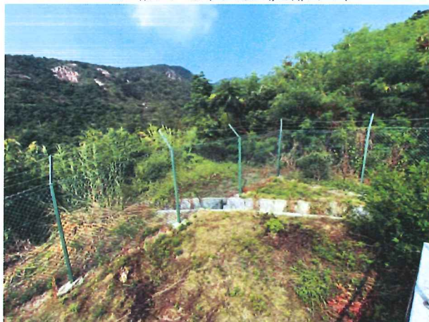
03 水箱西北侧截洪沟
