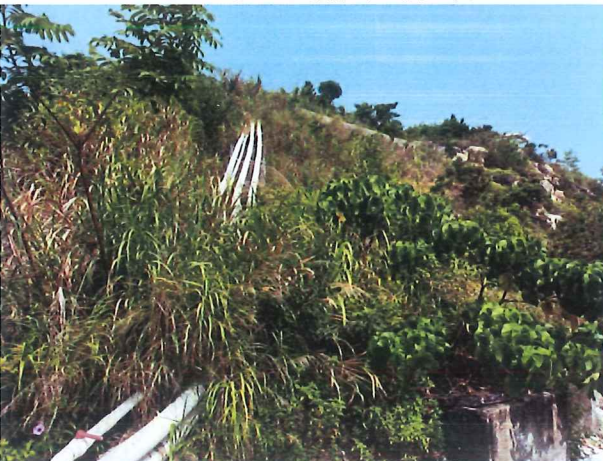
11 输水管周边绿化防护现状
