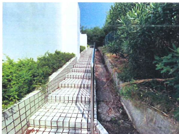
02 水箱四周永久排水沟
